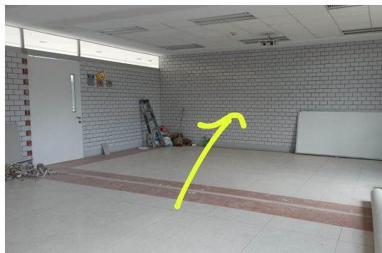
Ampliación del espacio, mediante la eliminación del muro
