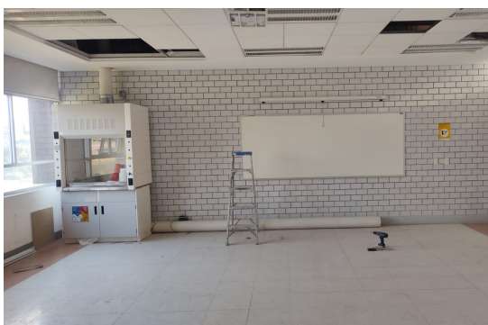
instalación de una campana de extracción, pizarrón y pantalla, así como la adecuación de la puerta
