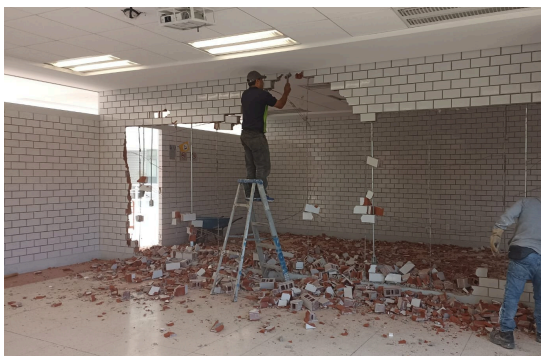
Ampliación del espacio, mediante la eliminación del muro
